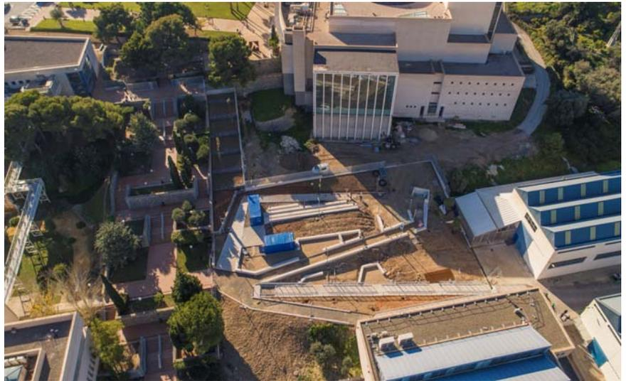
Obra: Contención de Talud de 18m de altura mediante pantalla de pilotes y micropilotes en Urbanización Altea Hills
